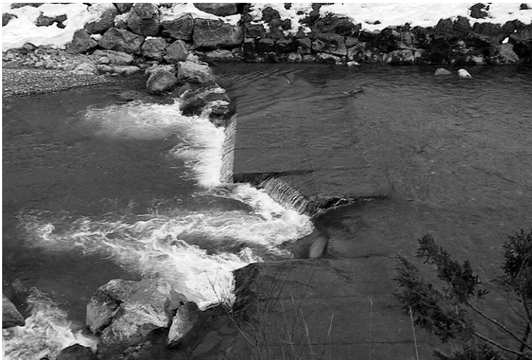
Abb. 2: Blockrampe an der Simme. Kolkbildung an der Sperrenkronen.
