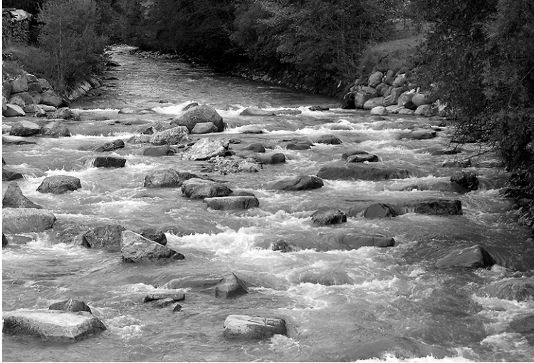
Abb. 1: Blockrampe an der Simme. Die Rampe erfüllt ihre Funktion auch nach dem Hochwasser.
