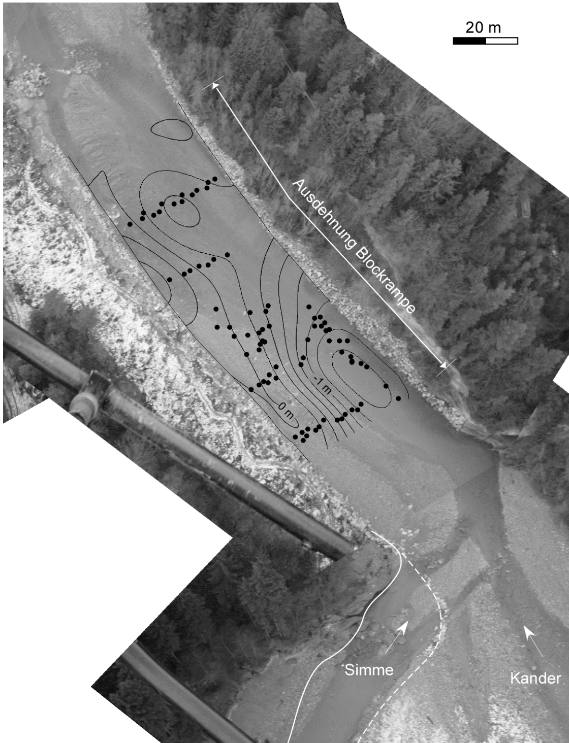
Abb. 6: Deformation der Blockrampe durch das Hochwasser 2005. Die Punkte zeigen die Stichprobe der ausgegrabenen Blöcke. Daraus wurde ein Differenzenmodell der tatsächlichen und der projizierten Oberkante der Blöcke gebildet (Konturen durch Kriging-Verfahren ermittelt). Die weißen Linien bezeichnen das linke Ufer der Simme vor und nach dem Hochwasser. Hintergrund: pseudo-entzerrte Schrägaufnahmen.
