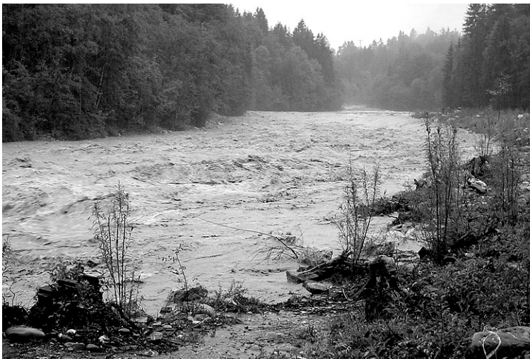
Abb. 4: Blockrampe an der Kander. Abfluss von 460 \text{ m}^3/\text{s} am Vormittag des 22. August 2005.
