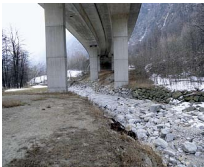
2 | Die Gefährdung durch Naturgefahrenprozesse wird nicht nur für Prozesse auf der Fahrbahn selber beurteilt, sondern für das gesamte Bauwerk. Hier galt es, die Gefährdung der Brückenpfeiler durch Unterkolkung zu beurteilen (Abbildung Judith Dobmann).
