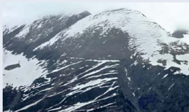
Auch in der Leventina wurden früher Lawinenanrissgebiete grossflächig mit Trockensteinmauern verbaut, wie hier im Verbauungsgebiet Pecian/Quinto TI (Abbildung M. Blum).
