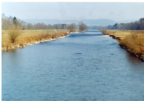
*Unterauf: Doppeltrapezprofil mit kleiner Aufweitung.*
