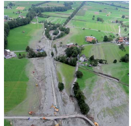
Bild 6. Schwemmkegel Dürrenbach. Aufgefüllte Bachschale mit Übersarungen und Geschiebesammler (Hintergrund). (Flugbild Kapo ZH).
