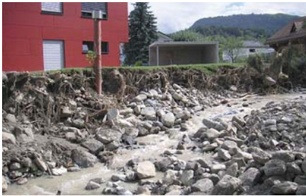
Bild 4. Auerbach. Ufererosion Oberau. Blick flussaufwärts. (Foto Bänziger Partner AG).
