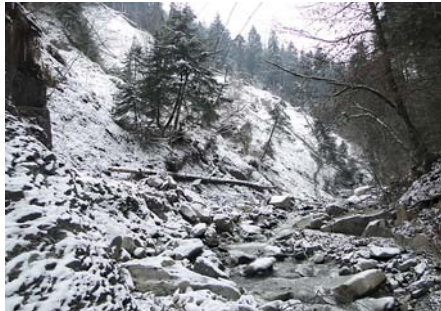
Bild 2. Tobelstrecke Auerbach. Grosser Hangrutsch mit abdriftenden Baumgruppen. Blick flussaufwärts.
