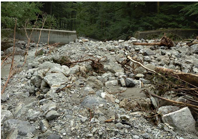
Bild 8. Kobelwiserbach. Geschiebeablagerungen flussaufwärts einer Wildbachsperre. Blick flussabwärts. (Foto Bänziger Partner AG).
