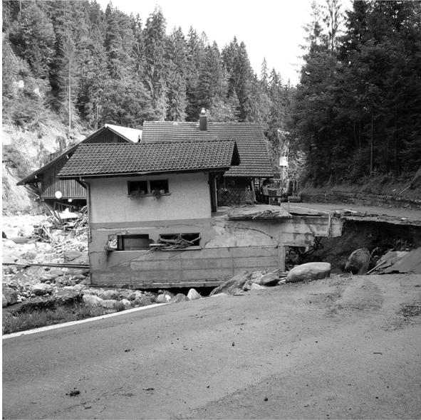
**Abb. 7:** Durch Gerinneverlagerung beschädigtes Gebäude und zerstörte Talstraße.
