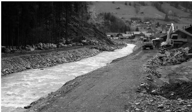
**Abb. 9:** Hochwasserschutzdamm als Sofortmaßnahme zum Schutz des Dorfes Oey.
