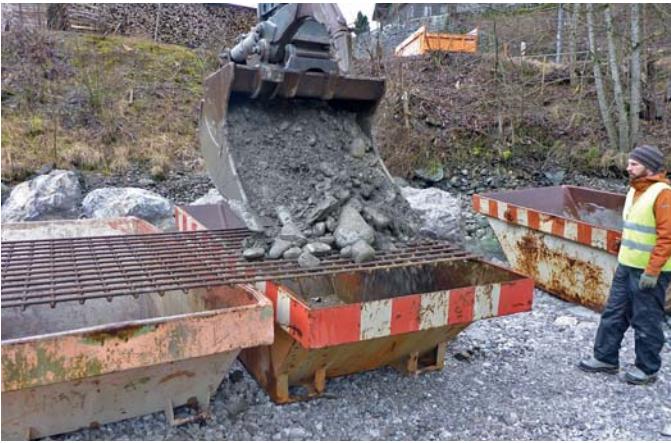
Bild 8. Siebanalyse des Untergrundmaterials (Simme, Bäuert-weidli), Aussieben der groben Komponenten.
