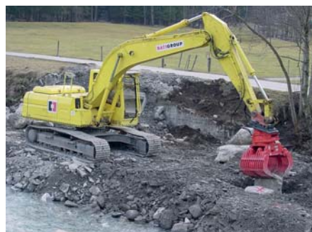
Bild 3. Ausführung einer aufgelösten unstrukturierten Blockrampe an der Simme in St. Stephan: Die Blöcke werden in das Planum eingegraben.
