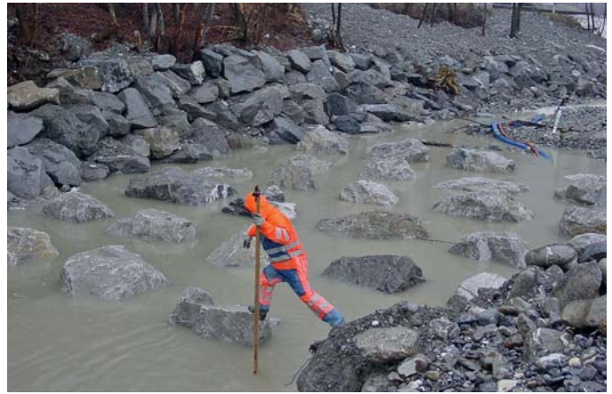
Bild 9. Kontrolle der Positionierung der Blöcke (Simme, Latterbach).
