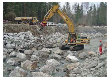
Bild 4. Anschluss der aufgelösten unstrukturierten Blockrampe an die Ufersicherung: Die Ufersicherung wird zuerst erstellt, dann werden die Blöcke der Rampe versetzt (Kander).
