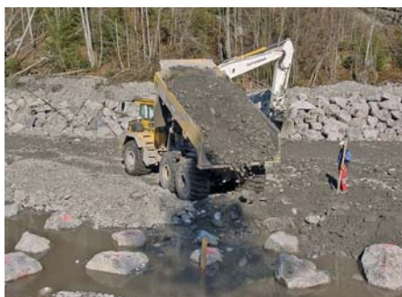
Bild 2. Ausführung einer aufgelösten unstrukturierten Blockrampe an der Kander: Die Blöcke werden auf das Planum aufgesetzt und anschliessend mit Untergrundmaterial überschüttet.
