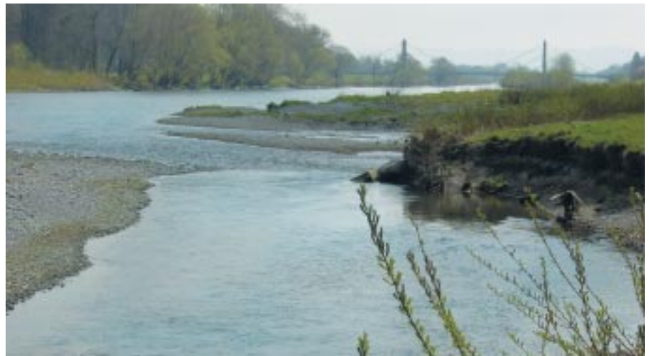
Bild 9. Ufererosion in leicht erodierbaren Feinsedimentablagerungen und Sicherung mit Buhnen. Aufweitung der Thur bei Altikon (Kanton Zürich).
