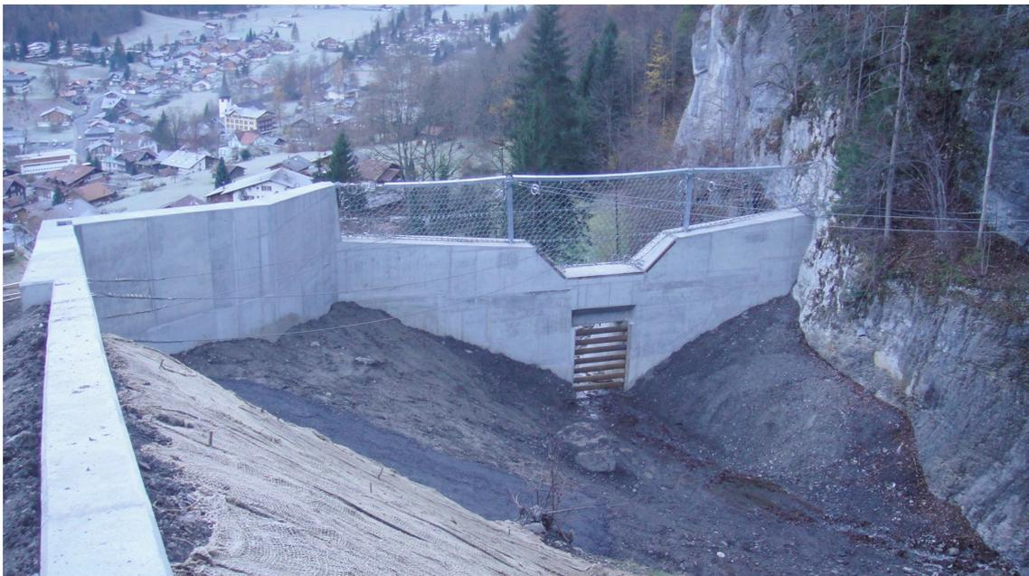
Abb. 2: Rückhalteraum des erweiterten Geschiebesammlers nach Fertigstellung
